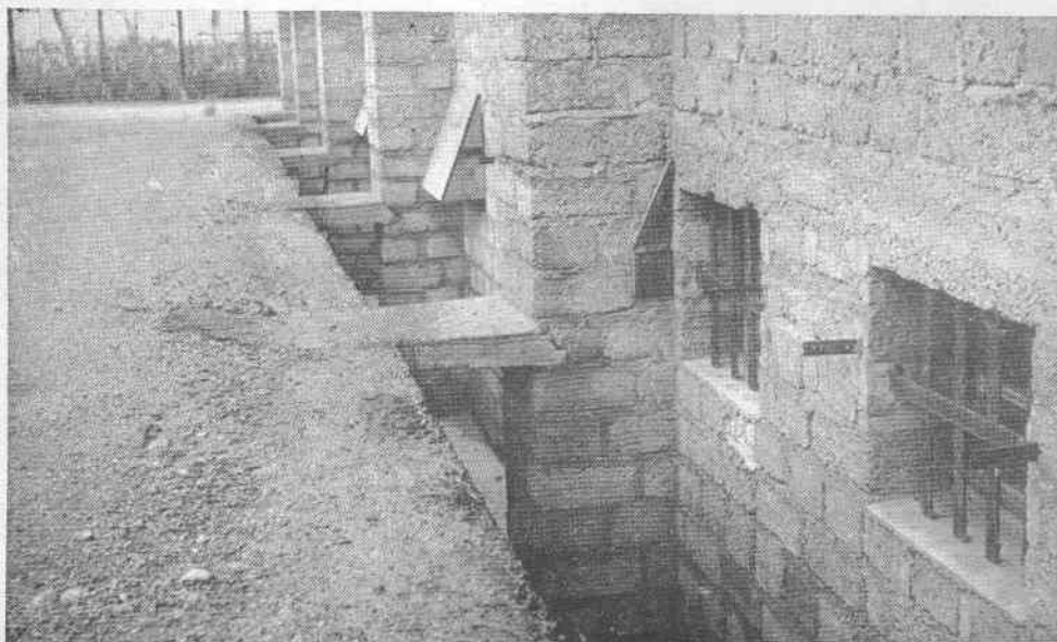
Fenêtres occultées du Bunker.
